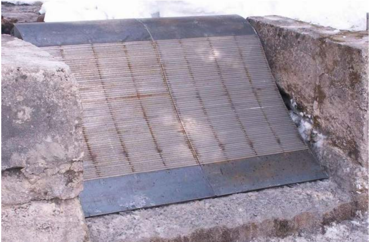
Abbildung 14: Coanda Wasserfassung im Lechtal, Tirol (Foto: wasserkraft.npage.at/coanda-funktion.html )
