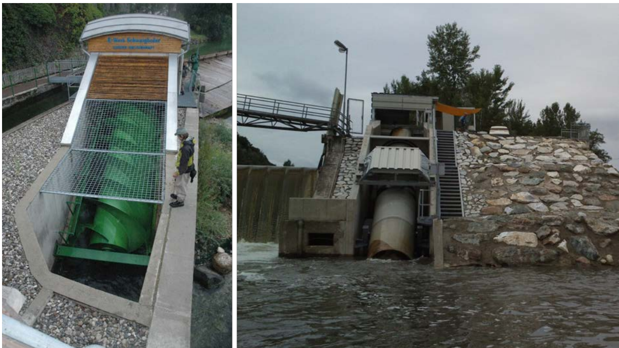
Abbildung 7: Links: Wasserkraftschnecke; Rechts: Drehrohr-Doppelwasserkraftschnecke.
